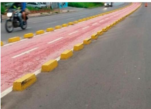
Figura 18: Modelo de ciclovía bidirecional com separador de concreto
